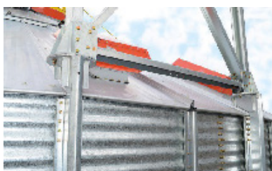
Apoios da passarela.
