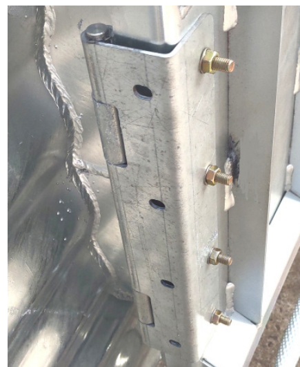
Nova Dobradiça Interna sem solda.
